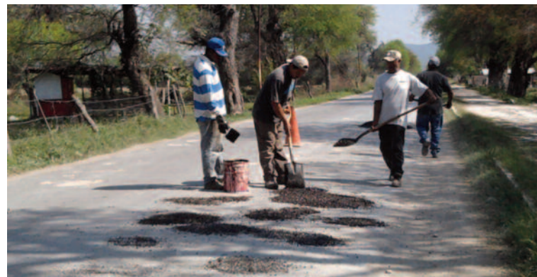
El Departamento de Obras Públicas comenzó campaña de bacheo.
